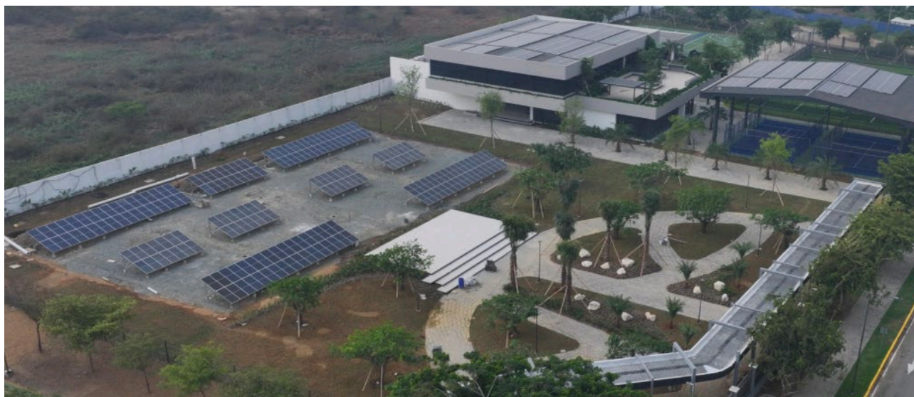
Figura 63. Parque Solar ECOTEC
