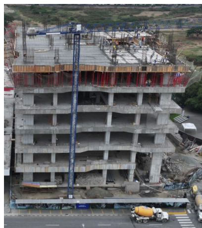
Figura 70. Construcción del Edificio A – Campus Samborondón
