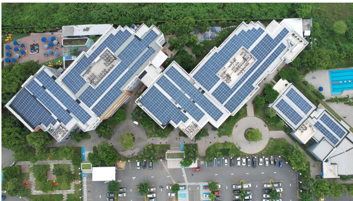
Fotografía 33. Vista panorámica de Planta Solar ECOTEC
