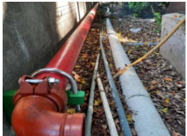
Instalación de sistema contra incendios
