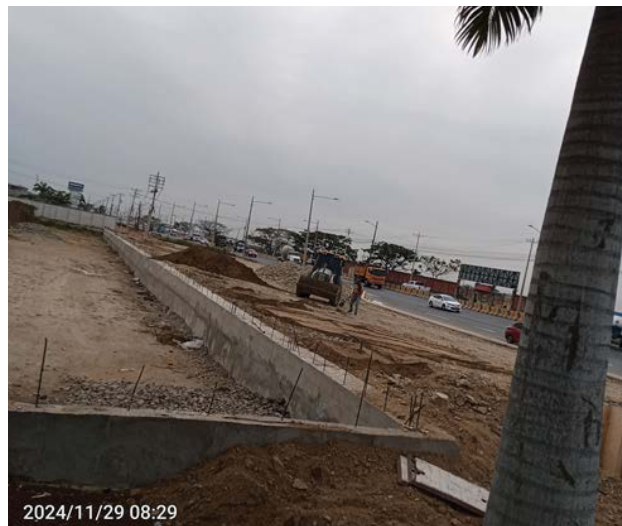
Construcción del cerramiento principal del Campus Samborondón
