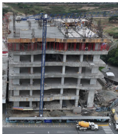
Figura 70. Construcción del Edificio A – Campus Samborondón
